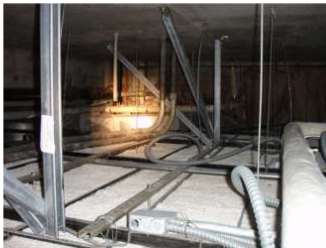
شکل پ ۶-۳۱- سقف لایه گچی با مهار جانبی در فواصل ۱٫۸ تا ۲٫۴ متری
